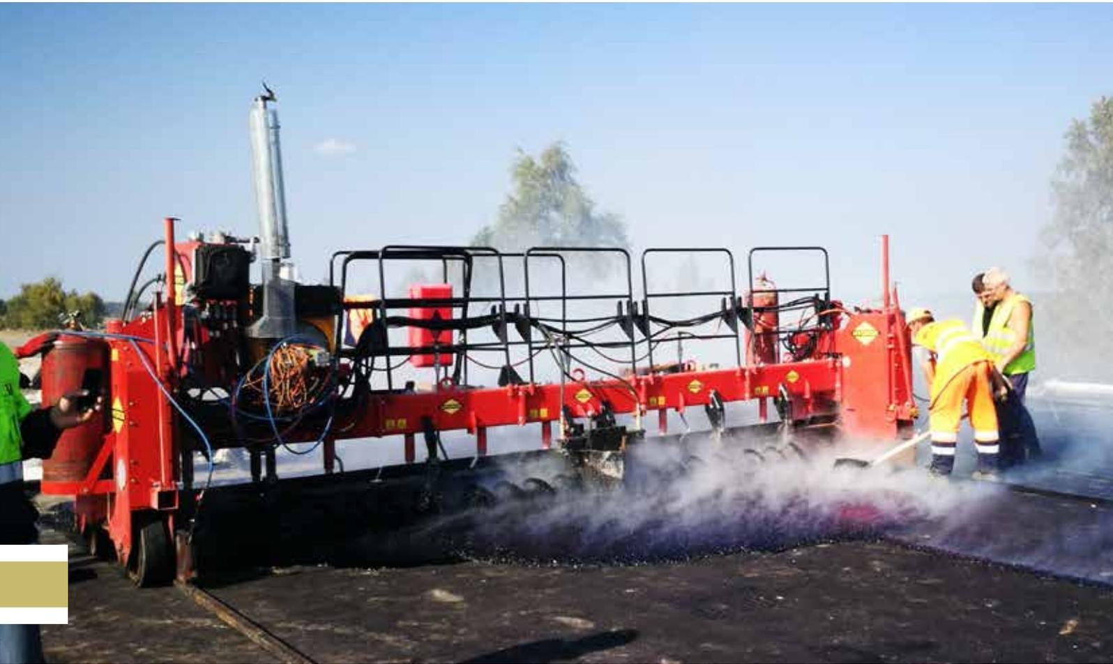
**Gussasphaltpfertiger HYDROG RAL-5500 und RAL-7500 werden zum maschinellen Verlegen, Gleichsetzen und Verdichten von Gussasphaltschichten mit einer erhitzten Abzugsleiste (Schar) bei der Herstellung von Folgendem, verwendet**
